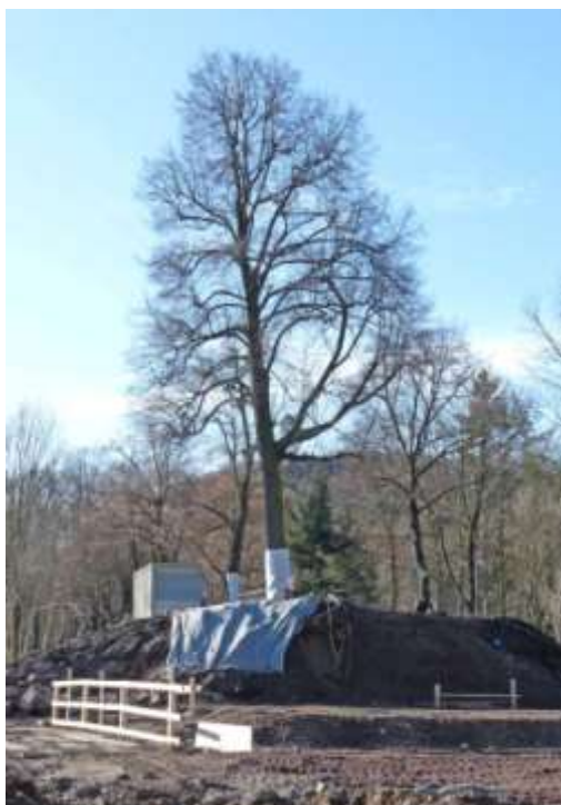
Baumaßnahme mit Baumschutz in Freital 2010 - ob's wohl geholfen hat?
